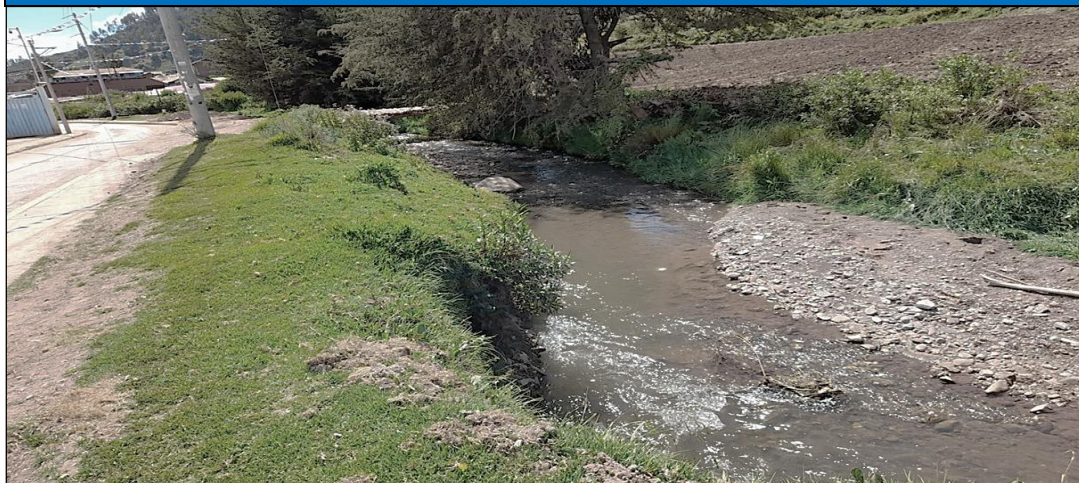
FIGURA N°01: BASE DEL TALUD DEL RIO SE OBSERVA EL SOCAVAMIENTO Y EROSION DEL MISMO EL CUAL DEBILITA Y PODRIA AFECTAR EL PUENTE Y VIVIENDAS.
