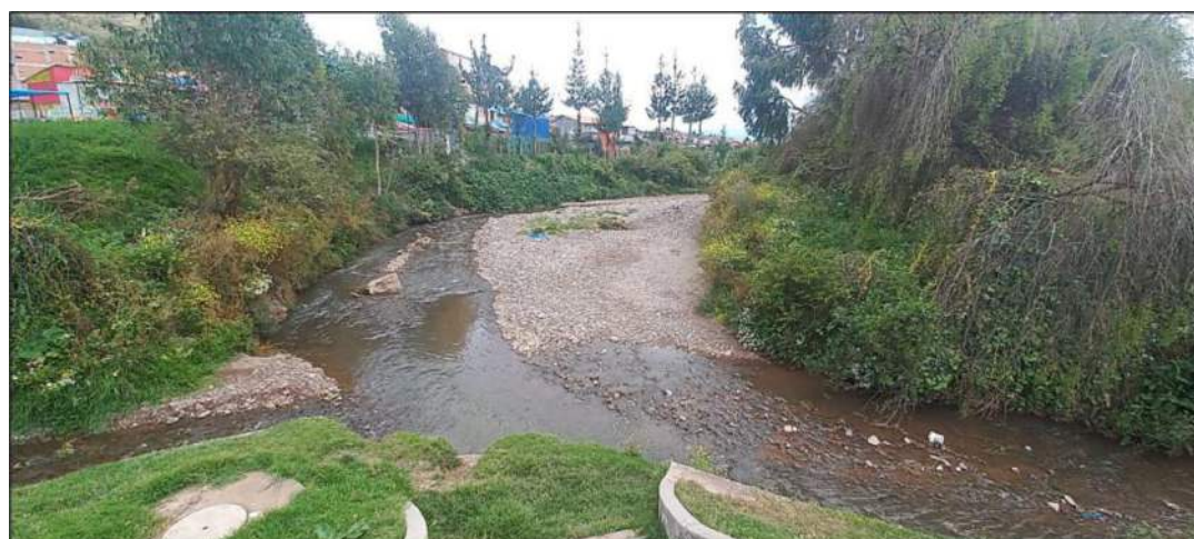
FIGURA N°03: BASE DEL TALUD DEL RIO SE OBSERVA EL SOCAVAMIENTO Y EROSION DEL MISMO EL CUAL DEBILITA Y PODRIA AFECTAR EL
